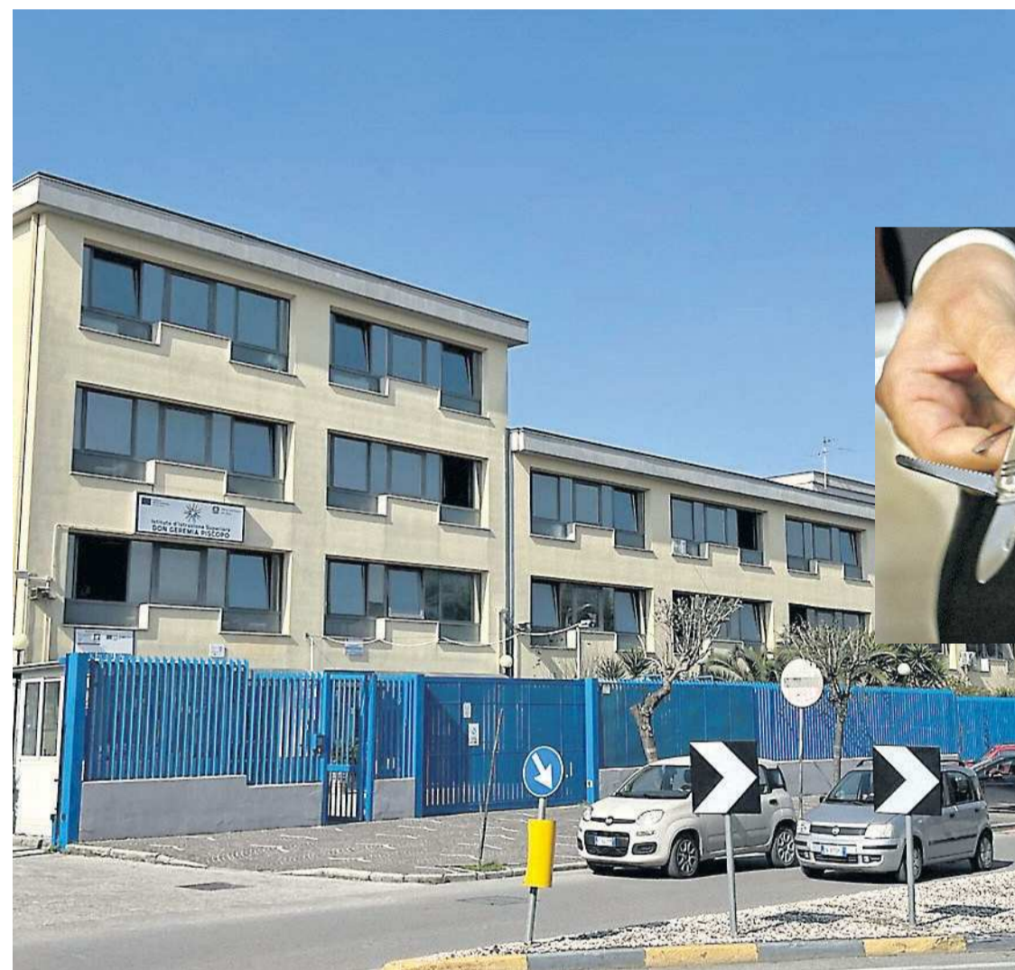
LA STRUTTURA La scuola «don Geremia Piscopo» è un istituto professionale con corsi di specializzazione tra i più avanzati dal punto di vista tecnologico
